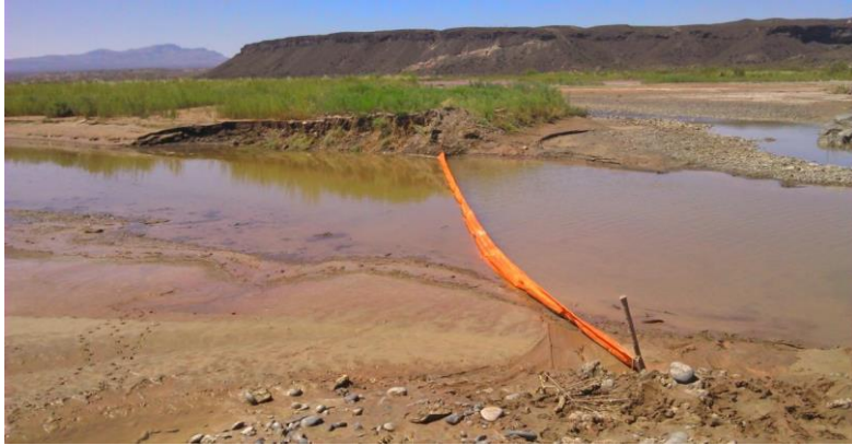
Tendido de Barreras en brazos temporales del Río Colorado
