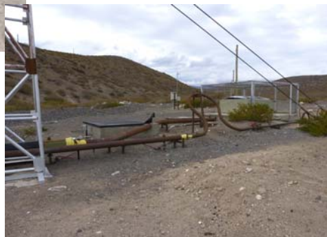
Verificación del saneamiento y de la modificaciones realizadas
