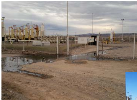
Incidente en separador de Batería
