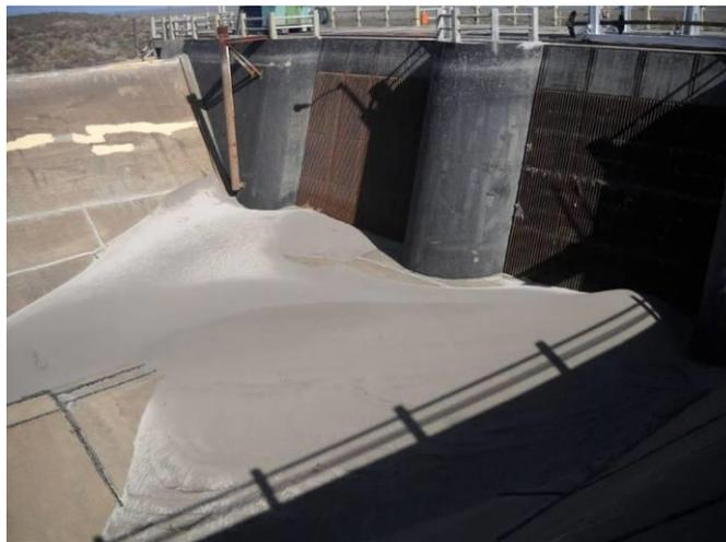
*Depósito de arena en rejas de aducción de la Central Hidroeléctrica Los Divisaderos*
