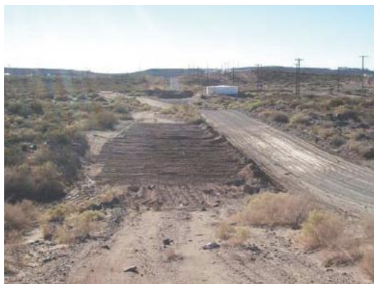
Se observa picada de oleoducto saneada (zona escarificada).
