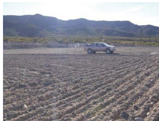
Se observa locación de pozo inyector saneada (zona escarificada).
