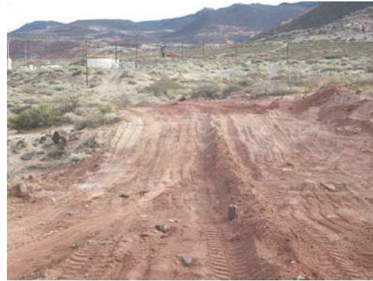
Se observa picada de línea de conducción de pozo productor saneada.
