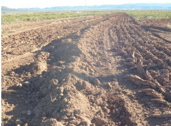
Se observa picada de acueducto de inyección saneada (zona escarificada).
