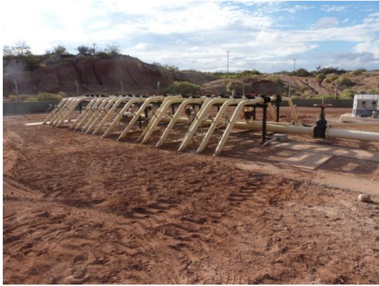
Se observa saneamiento de superficie afectada por rotura de línea de conducción en ingreso a colector.
