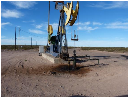
Se observan restos de hidrocarburo e instalación sin cerco perimetral
