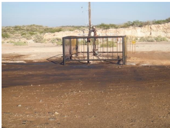
Se observa incidente en boca de pozo y locación, afectando suelo en locación (instalación).
