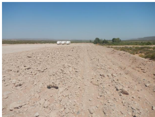
Se observa saneamiento de locación de pozo (zona escarificada).
