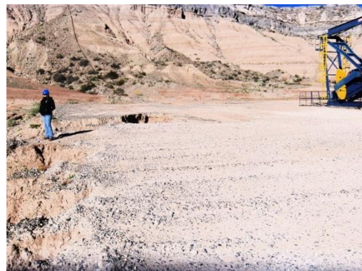
Se observa locación sin bordo/zanja perimetral y con erosión retrocedente hacia cauce aluvional
