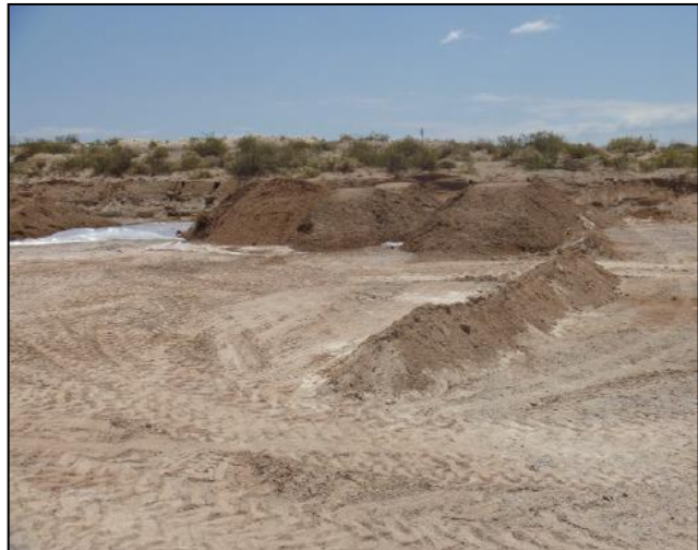
Se observa el suelo contaminado acopiado temporalmente sobre membranas plásticas.
