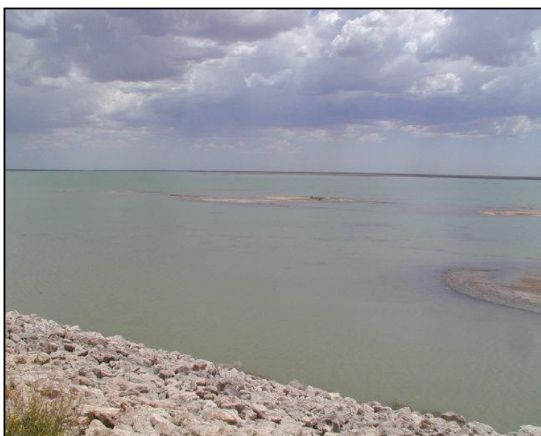
Vista bajante Lago Presa Casa de Piedra (imagen tomada desde margen izquierda hacia margen derecha)
