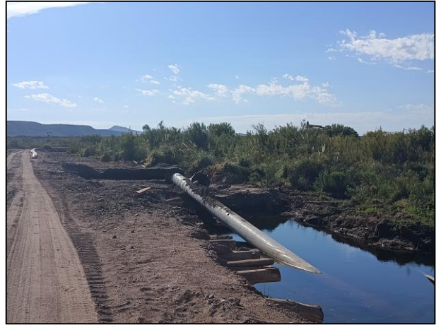
Fotos 7 y 8. Picada, ducto rígido (de acero) parte en excavación inundada y parte apoyado en superficie (en sus extremos) y tres ductos flexibles dispuestos libremente para posible conexión.
