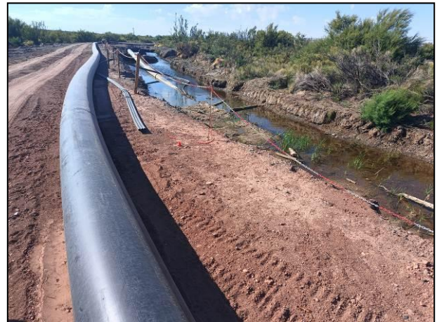
Fotos 5 y 6. Picada, ducto flexible en superficie y ducto rígido (de acero) parte en excavación inundada y parte apoyado en superficie (en sus extremos).
