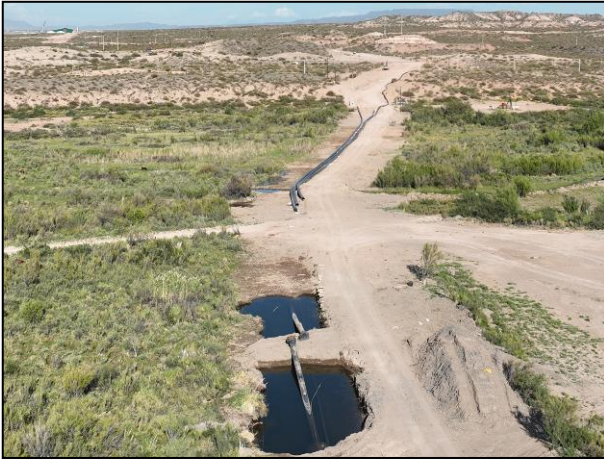
Fotos 7 y 8. Picada, ducto rígido (de acero) parte en excavación inundada y parte apoyado en superficie (en sus extremos) y tres ductos flexibles dispuestos libremente para posible conexión.
