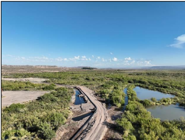
Fotos 5 y 6. Picada, ducto flexible en superficie y ducto rígido (de acero) parte en excavación inundada y parte apoyado en superficie (en sus extremos).
