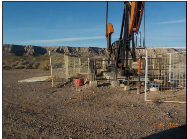
Foto 16. LB-1015. Reconstituir cerco perimetral, se observa el mismo parcialmente desarmado.
