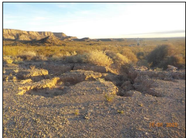
Foto 4. LB-1008. Reacondicionar Zanja/berma perimetral de contención de locación, erosionada en vértice Norte, formación de cárcava.
