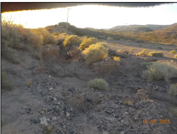
Foto 5. LB-1019. Reacondicionar Zanja/berma perimetral de contención de locación, erosionada en vértice Norte, formación de cárcava.
