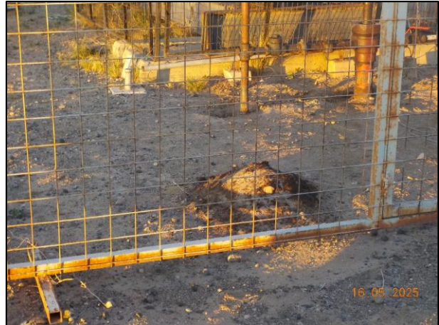
Foto 2. LB-1016. Retirar acopio de suelo con restos de hidrocarburos en boca de pozo.
